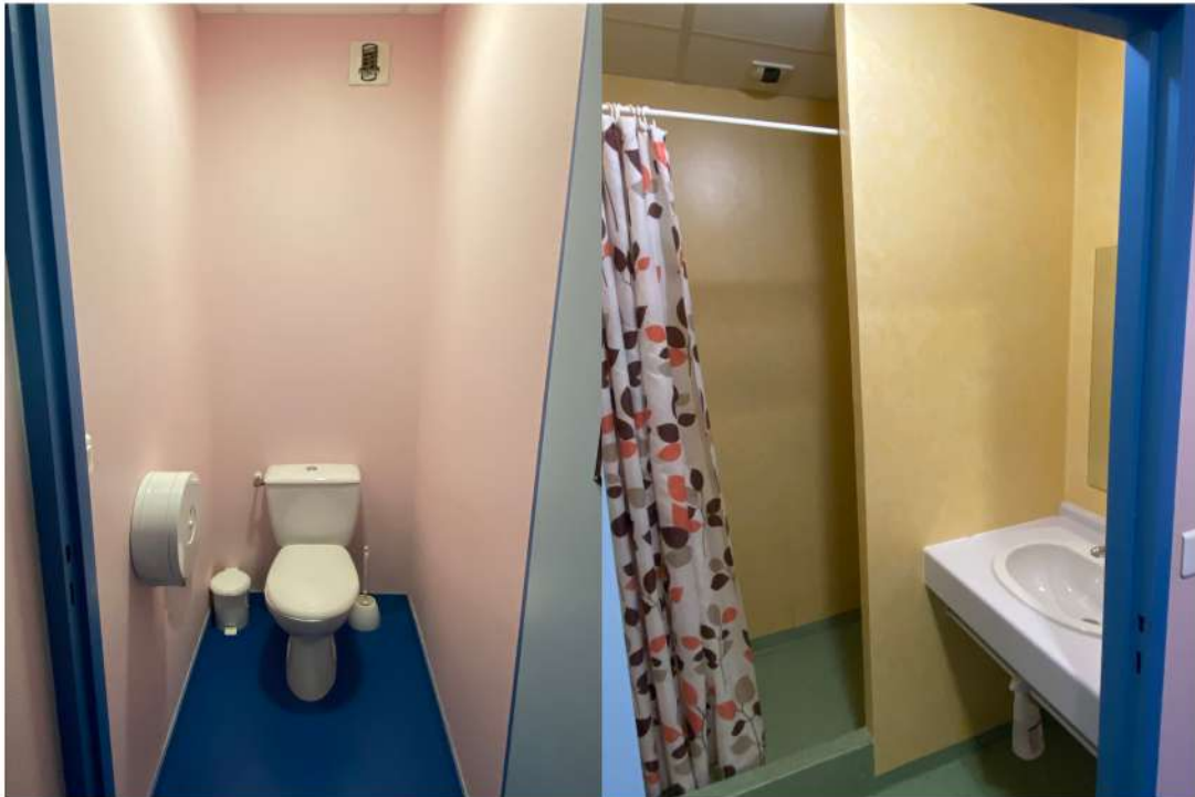
WC & Salle de bain d'une chambre basique
